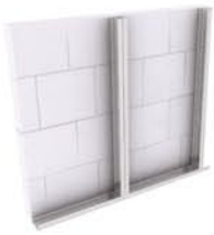
1. ติดตั้งโครงคร่าวบนผนังคอนกรีต
