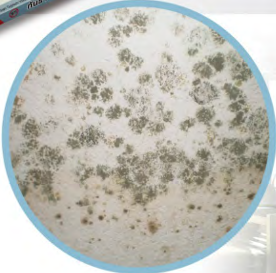
ภาพตัวอย่างเชื้อราที่ขึ้นบนฝ้าเพดาน
